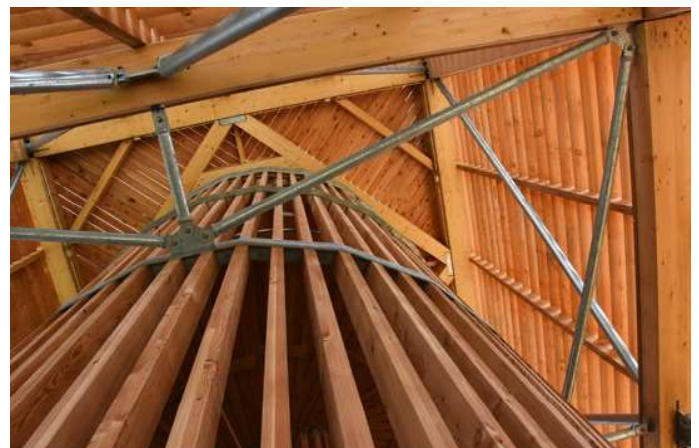
Die Kombination aus Holz und Stahl macht den Napoleonturm sturm- und erdbebensicher.
