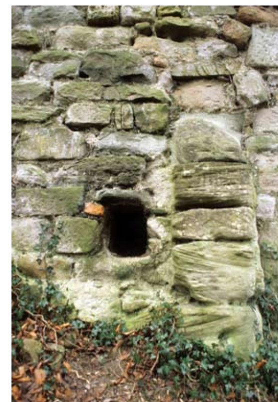
Sperrbalkenloch für Toranlage.
